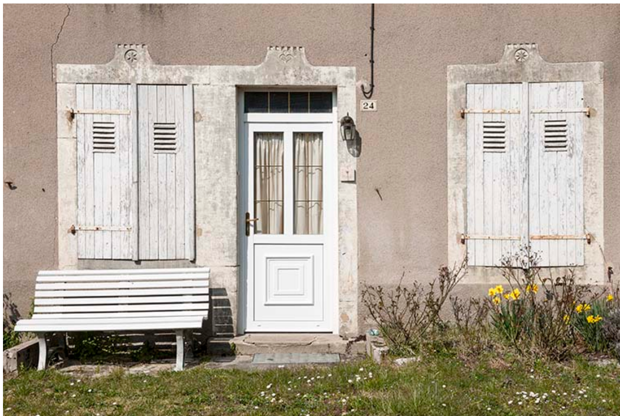
Porte d'entrée, façade principale.
