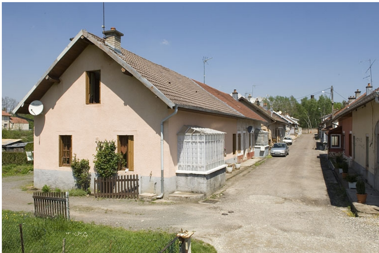
Vue d'ensemble de la cité ouvrière.
