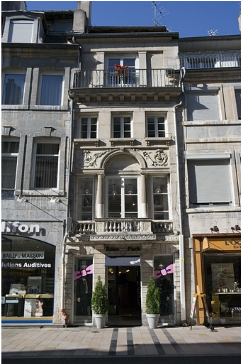
Vue d'ensemble de la façade sur rue, de face.
