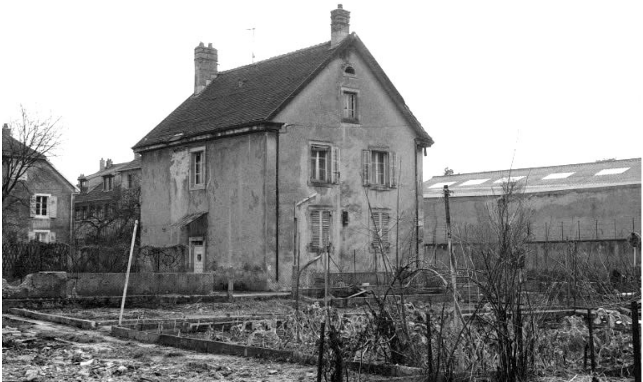
Façades postérieure et latérale gauche.
