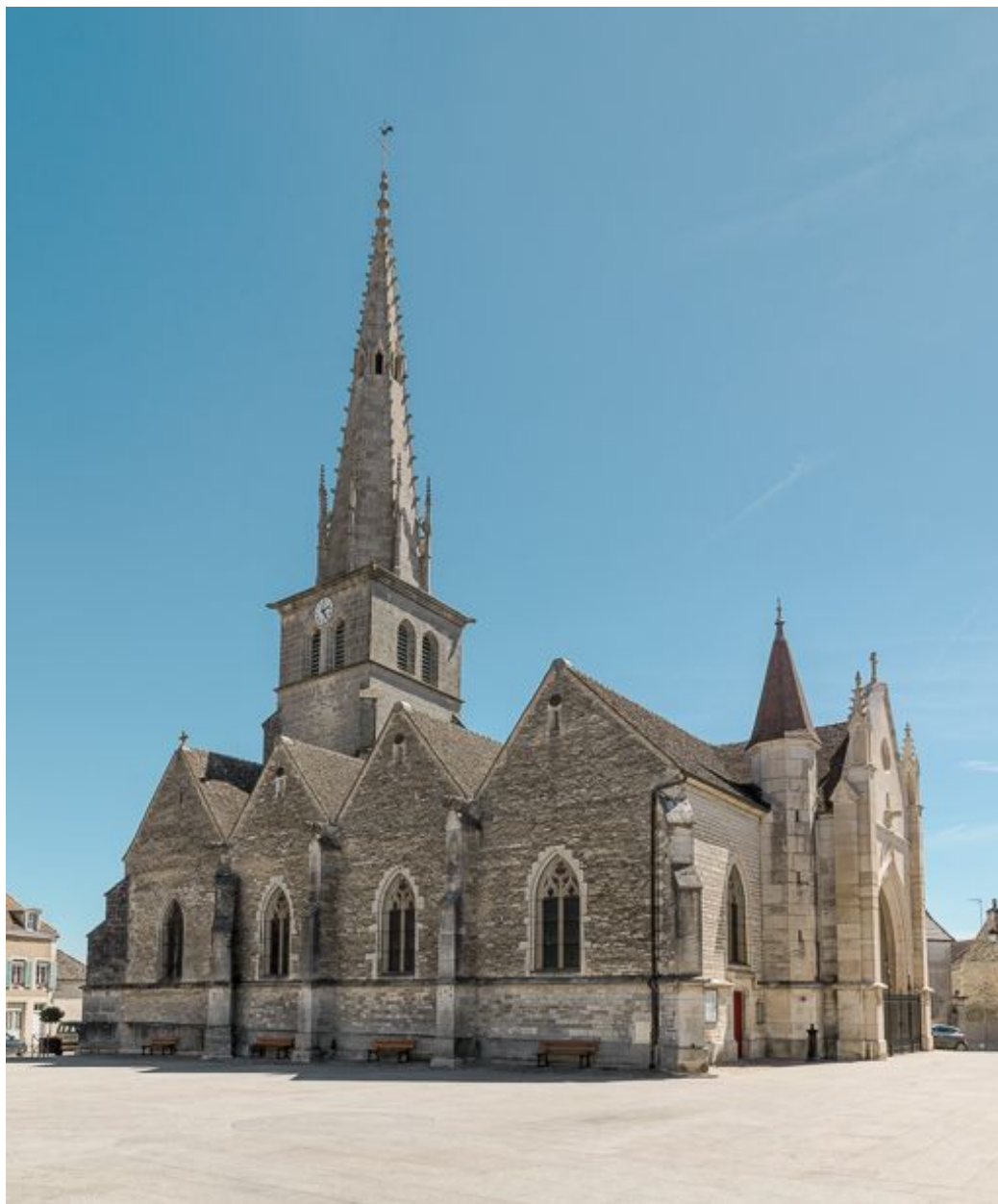
Vue d'ensemble de l'élévation nord.
