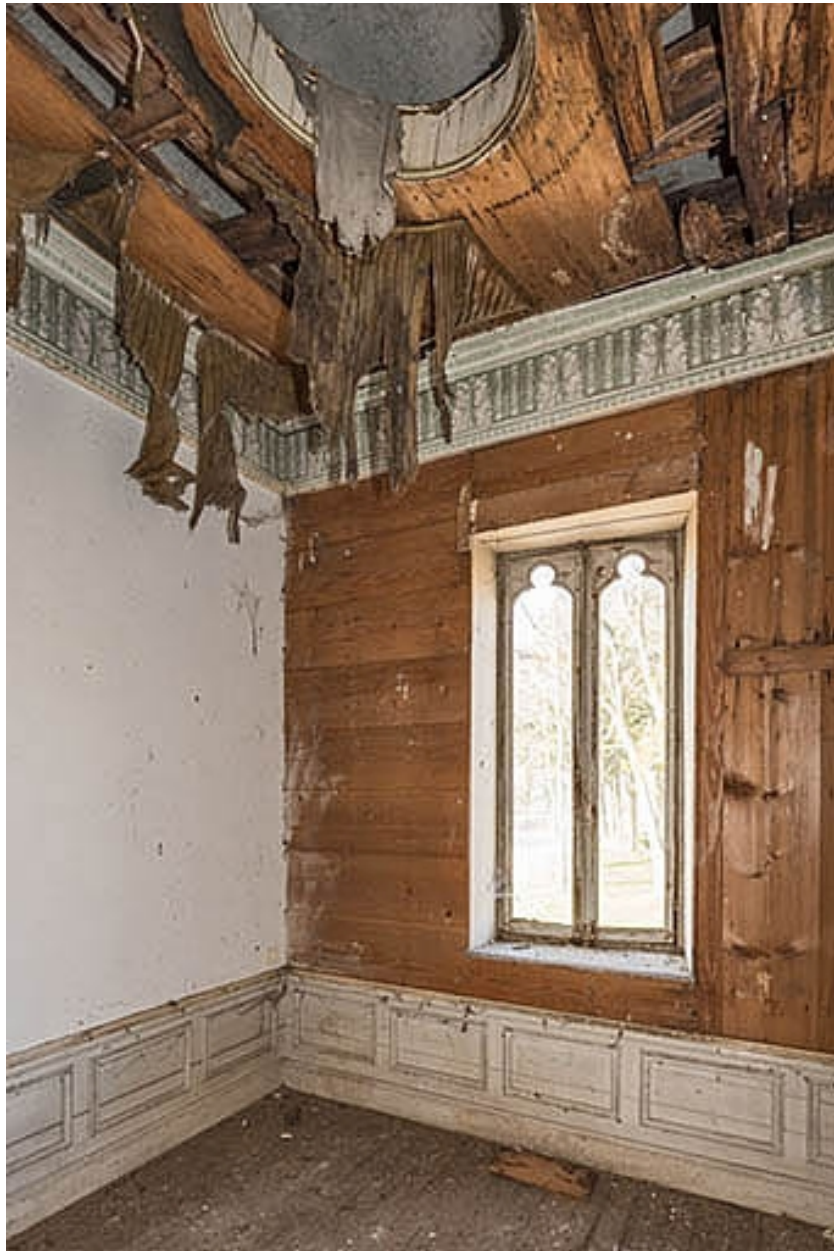
"Château neuf" : chambre à l'étage de la "Tour du Four".
