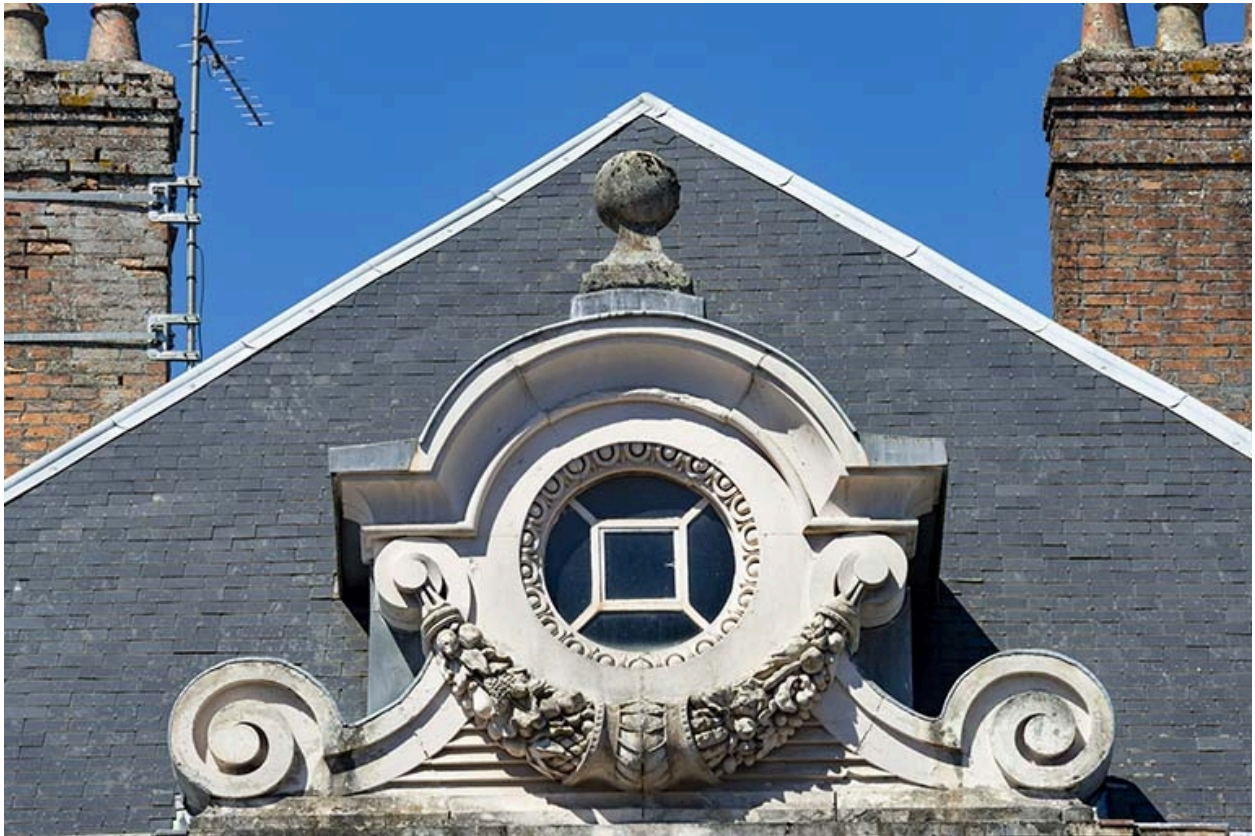
Façade est, détail de la grande lucarne, oculus sommital.
