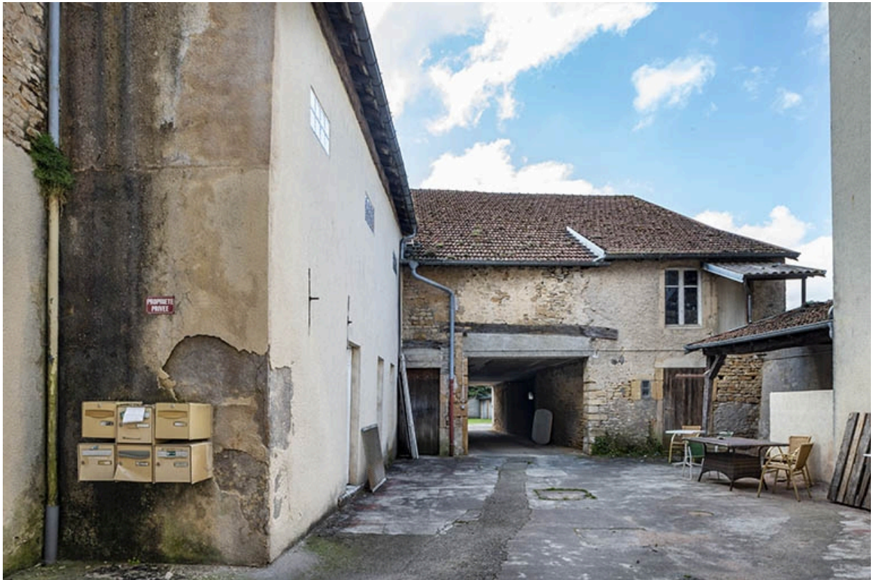
La rue Gambetta : n° 55, la cour vue en direction du sud.
