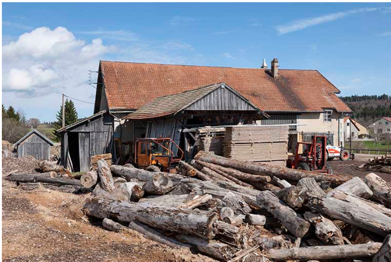
Vue depuis le sud.
