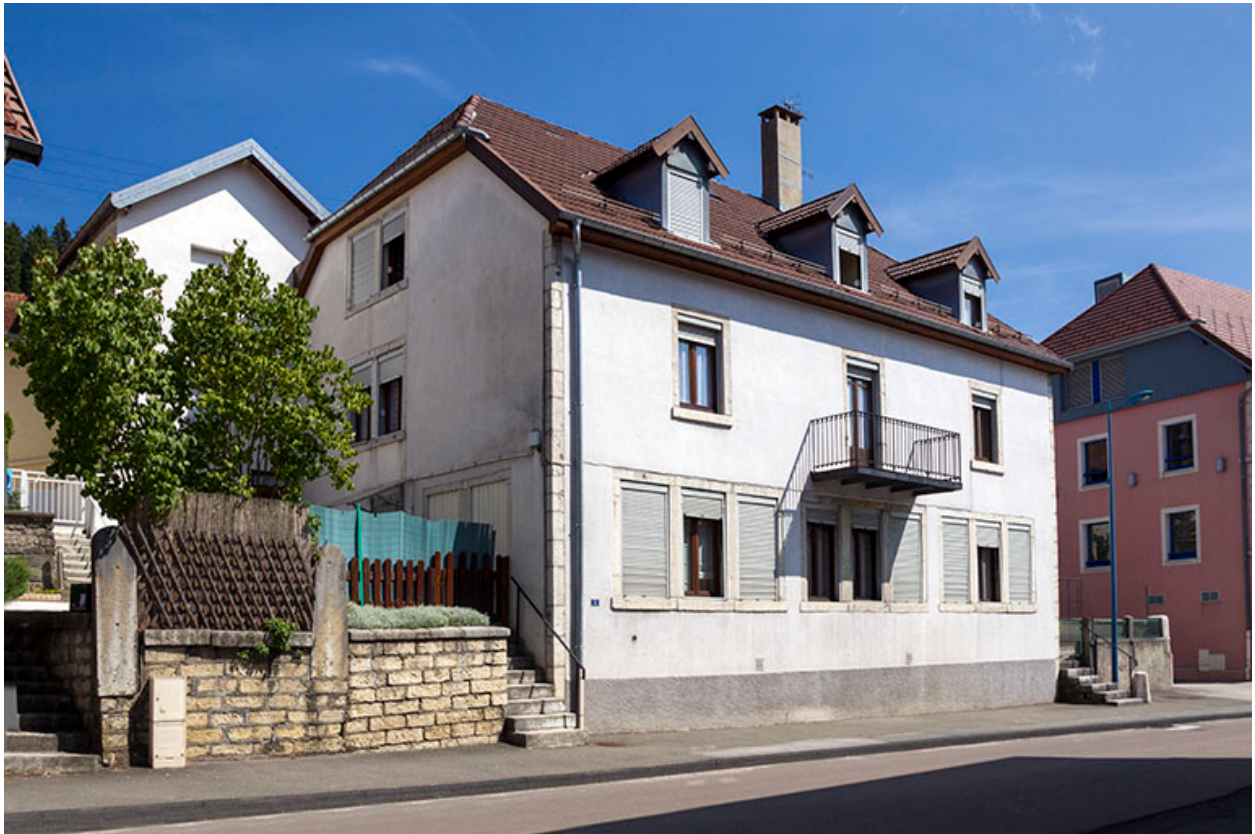
Façades antérieure et latérale gauche.
