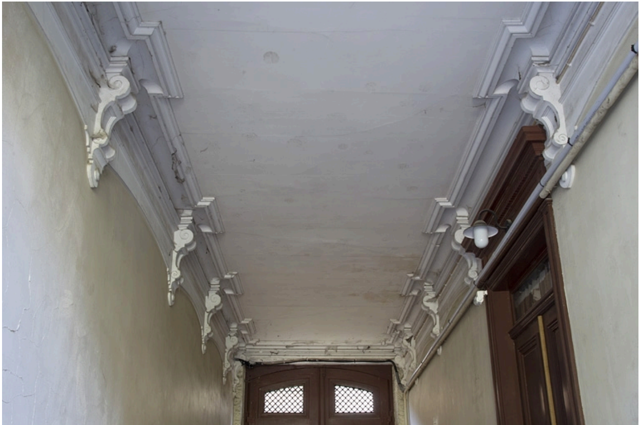
Deuxième logis secondaire : détail du plafond du passage cocher.
