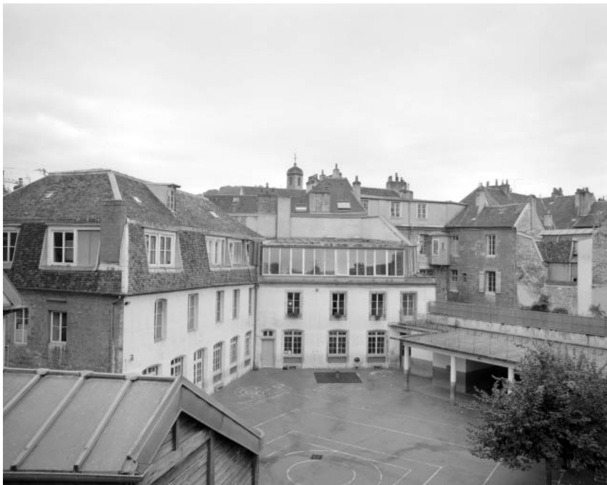
Vue d'ensemble de la deuxième cour.
