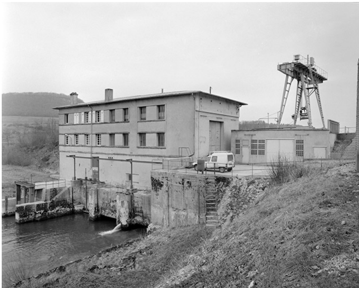
Salle des machines et atelier de réparation.
