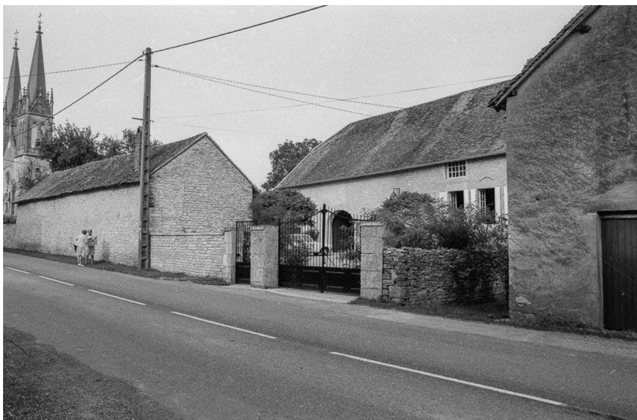
Vue d'ensemble depuis la rue Principale.
