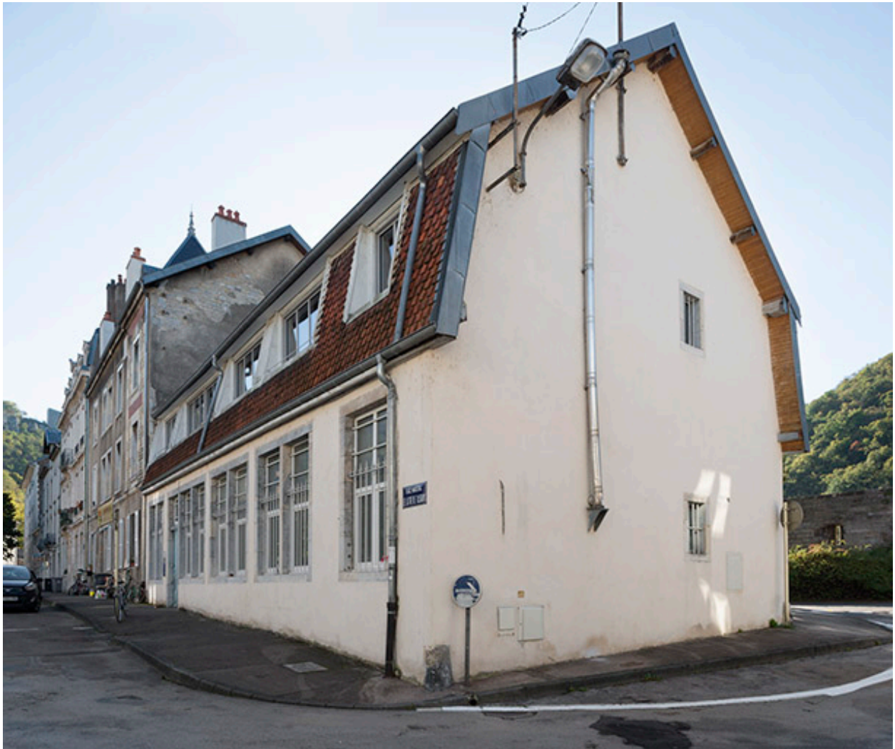
Façade et pignon ouest.
