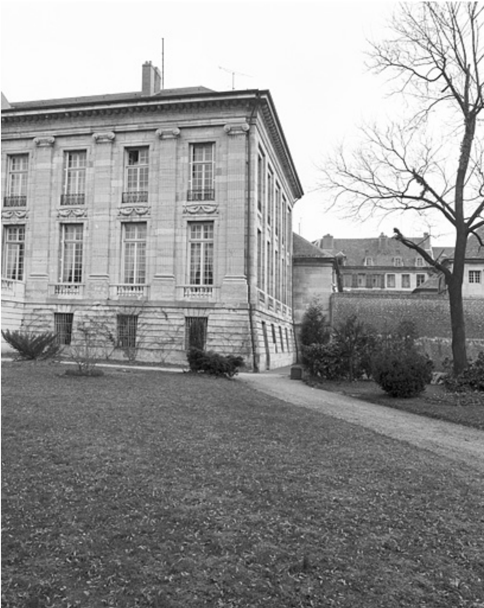
Façade postérieure : détail partie droite.
