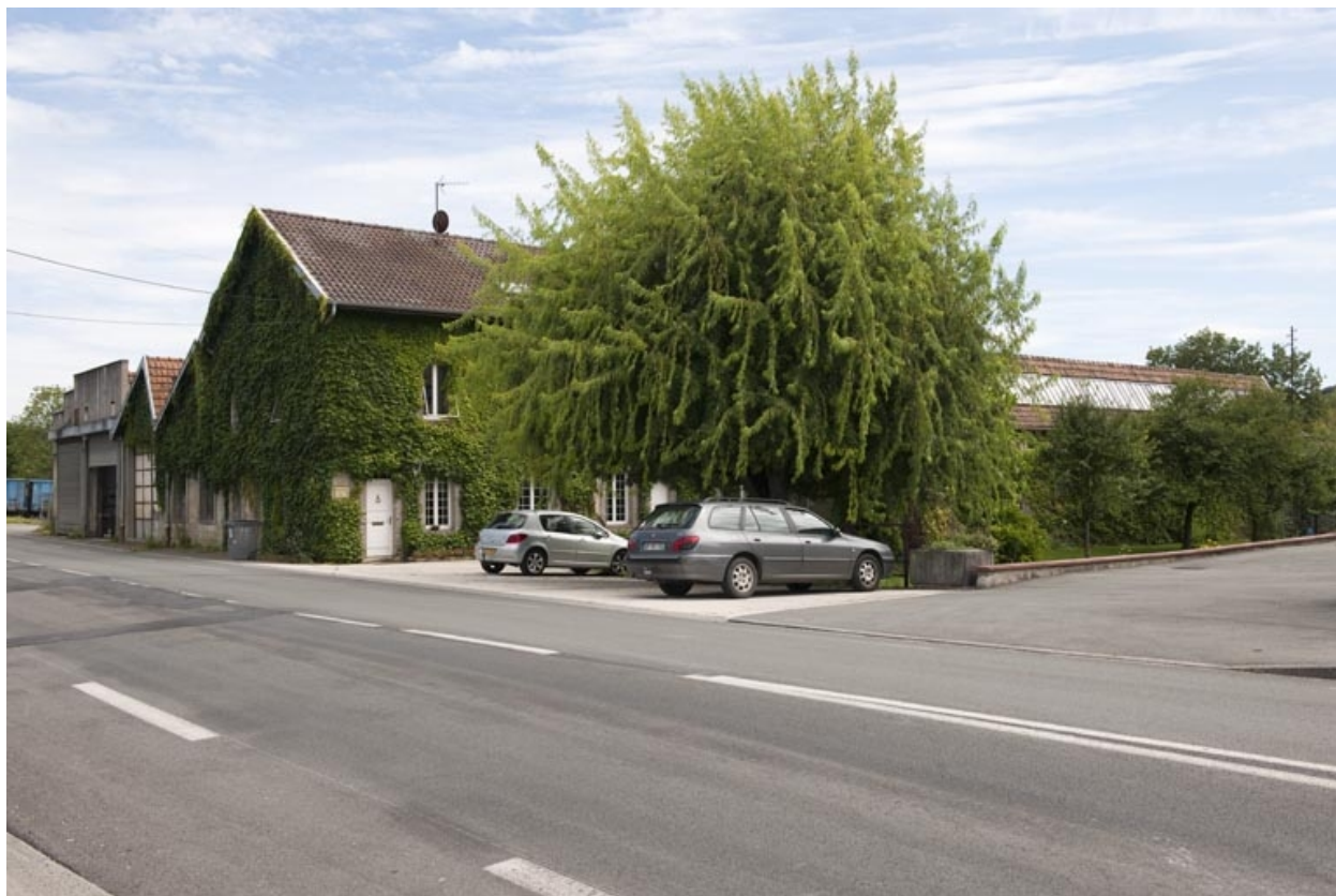
Vue d'ensemble depuis l'ouest.
