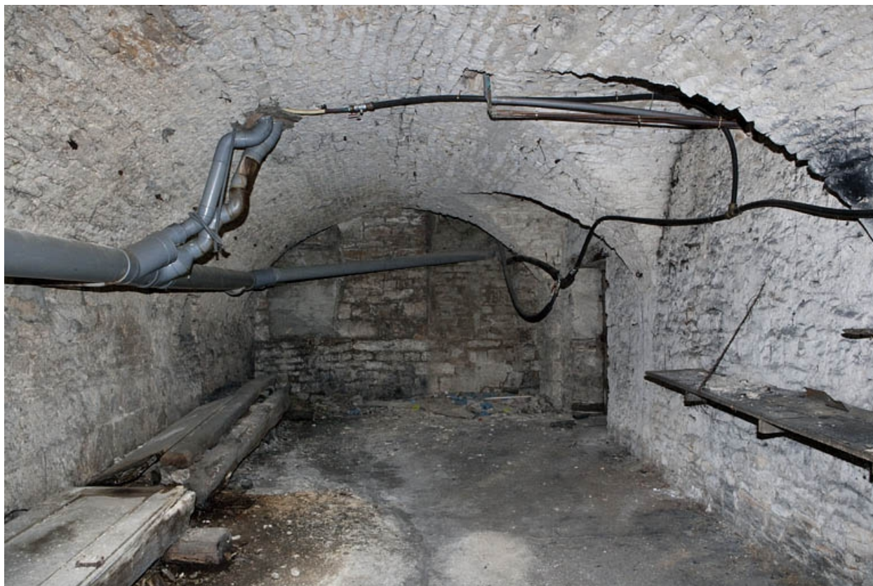
Logis principal, sous-sol : cave C, partie gauche.
