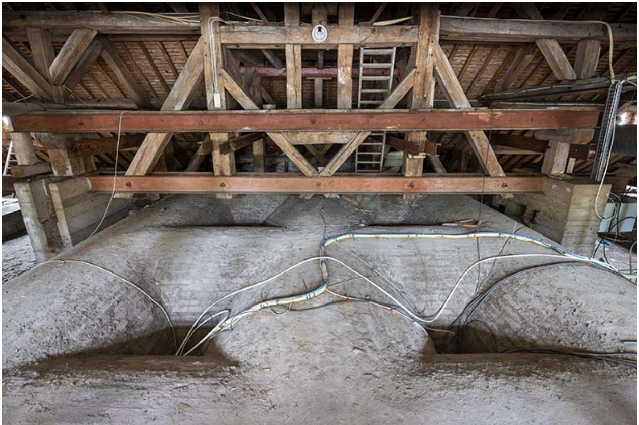
Voûte de l'ancien Bain des Cuvettes et charpente.
