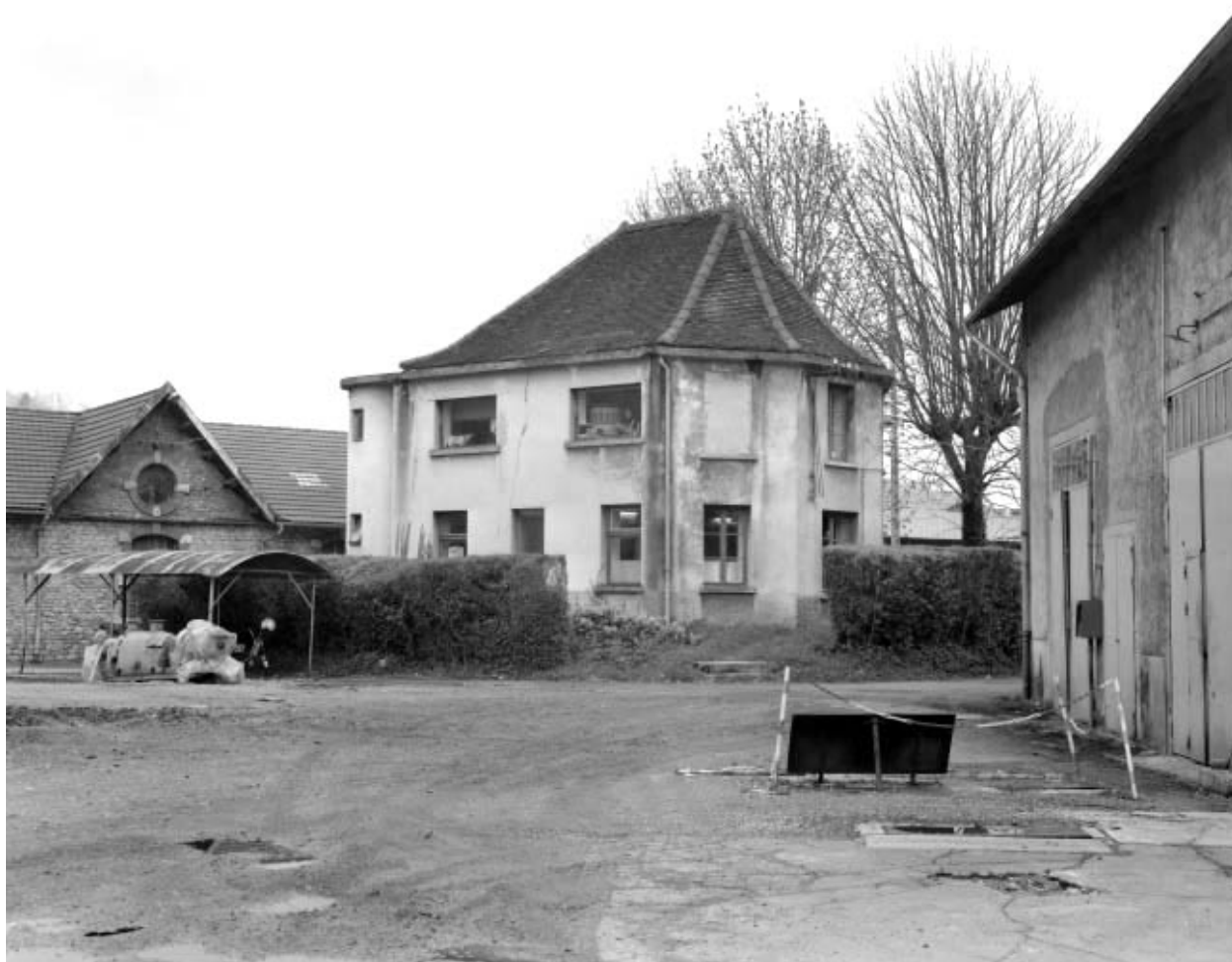
Façade postérieure des bureaux.
