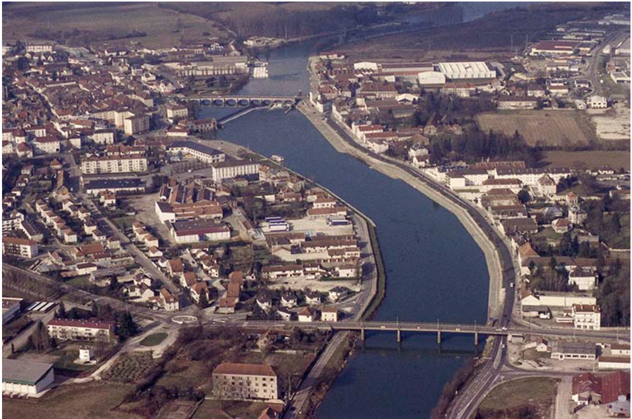
Vue aérienne de la ville basse et des deux ponts.
