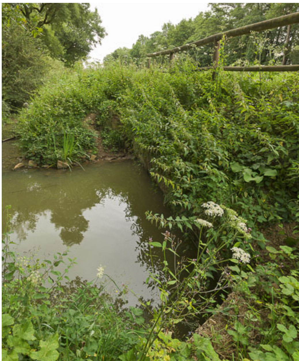
Vue de l'aqueduc.
