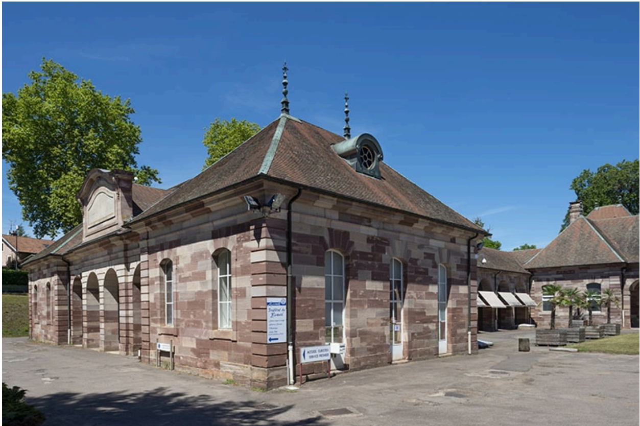
Bâtiment sud dit du Bain des Dames et du Bain des Bénédictins.
