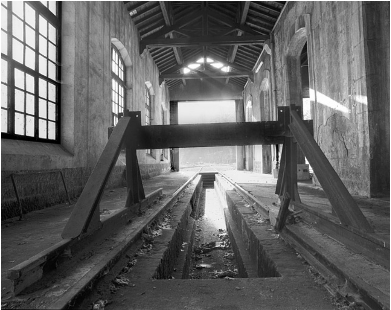
Remise ferroviaire : heurtoir et fosse à l'intérieur de la halle est.
