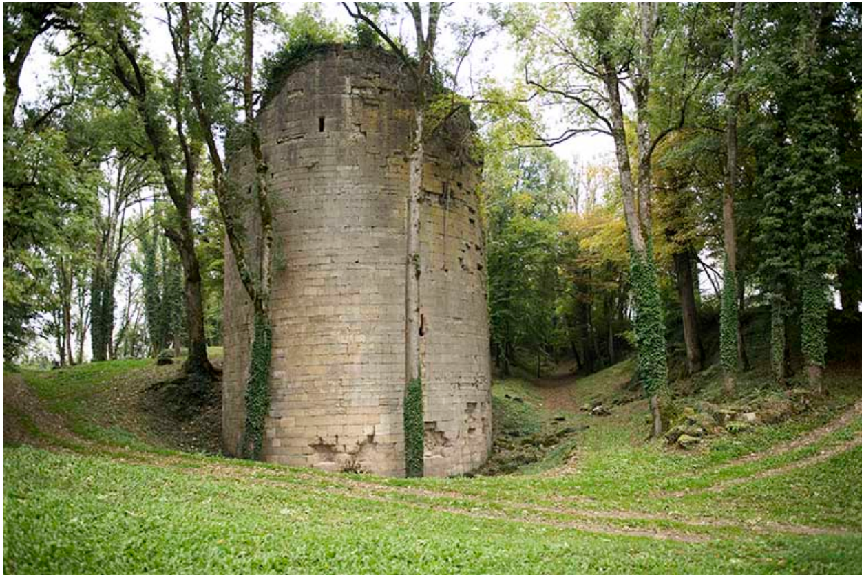
La tour ouest, vue de l'ouest.
