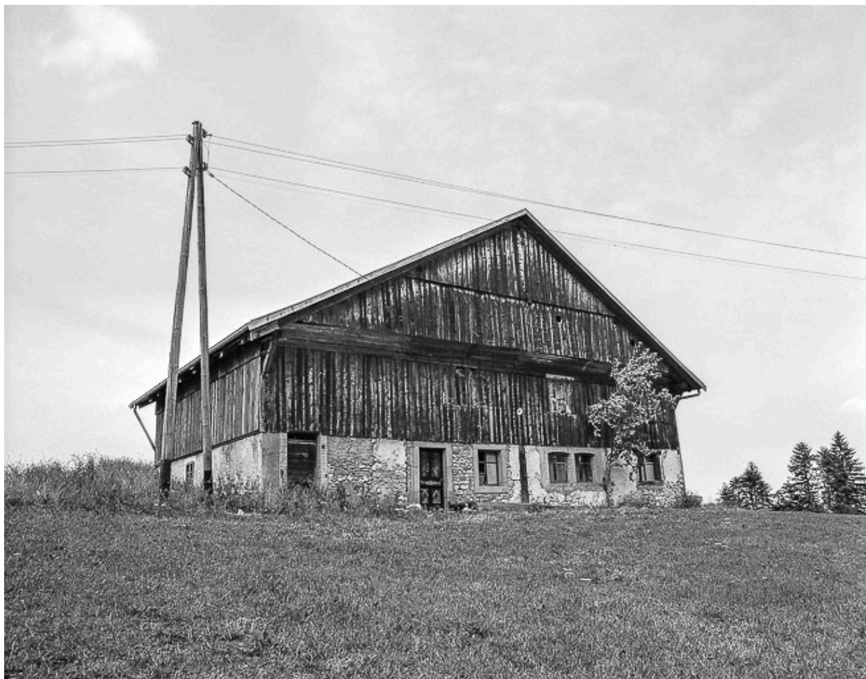
Ferme située au lieudit Les Petites Fontenottes, cadastrée 1966 C2 138 : vue d'ensemble.
