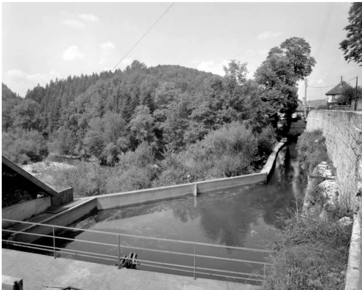
Bassin de retenue et canal d'amenée.
