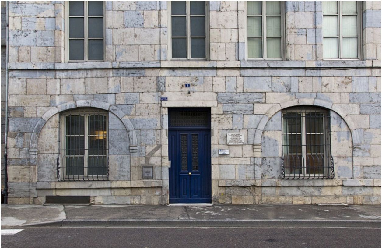
Logis principal, façade antérieure : détail du rez-de-chaussée, de face.
