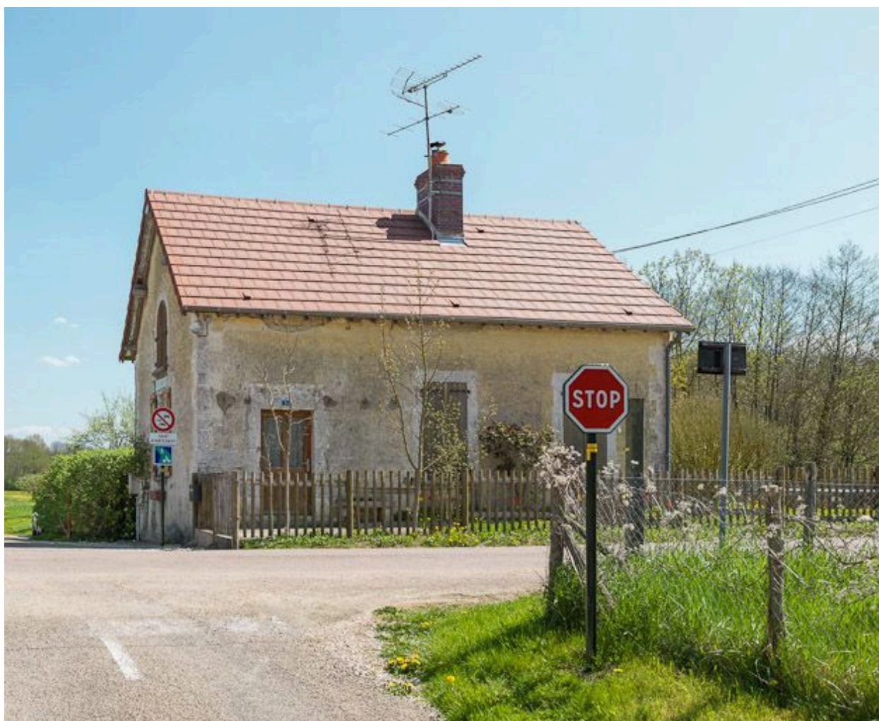
Maison éclusière, façade sur route.
