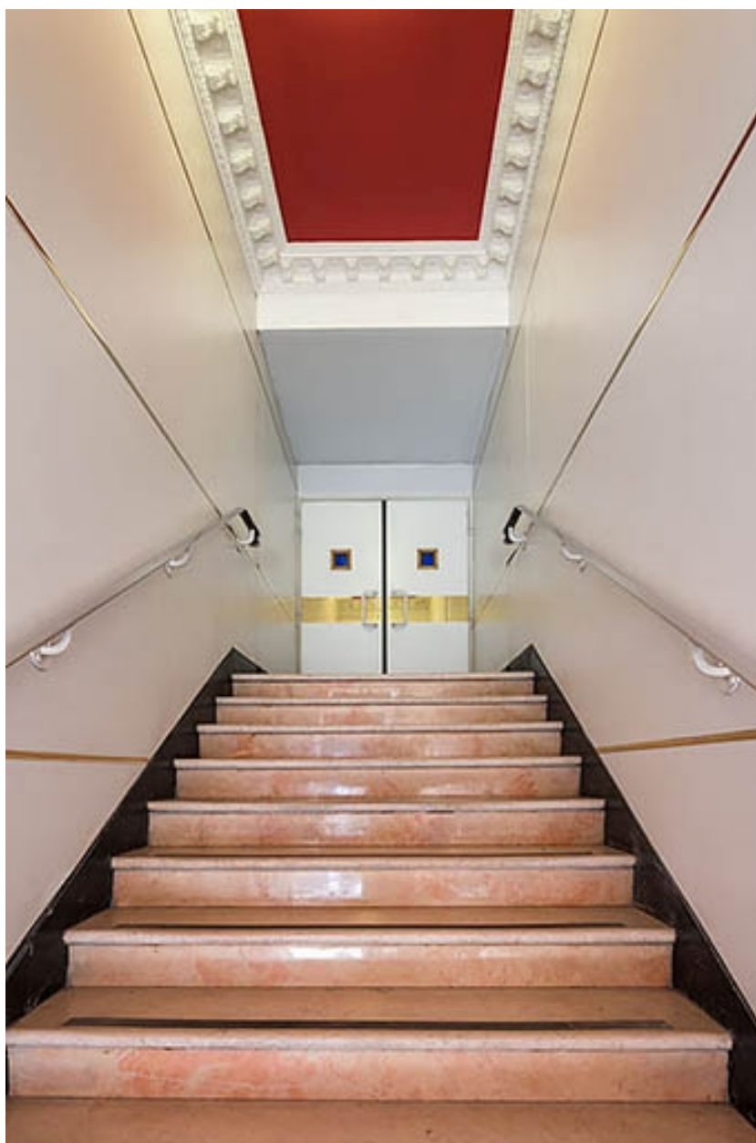
Escalier desservant la salle 2. Le plafond conserve un vestige du décor d'origine.
