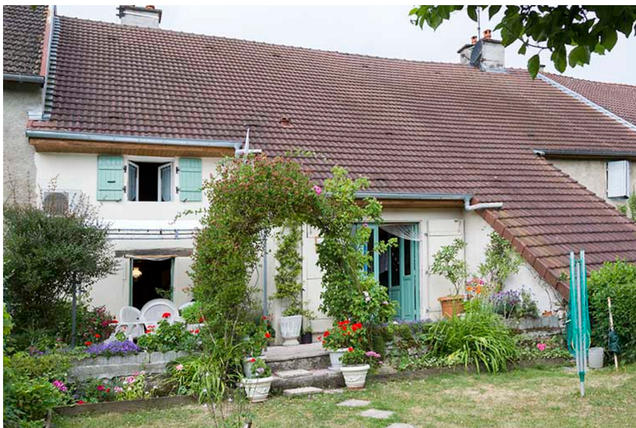
Façade postérieure côté Saône.
