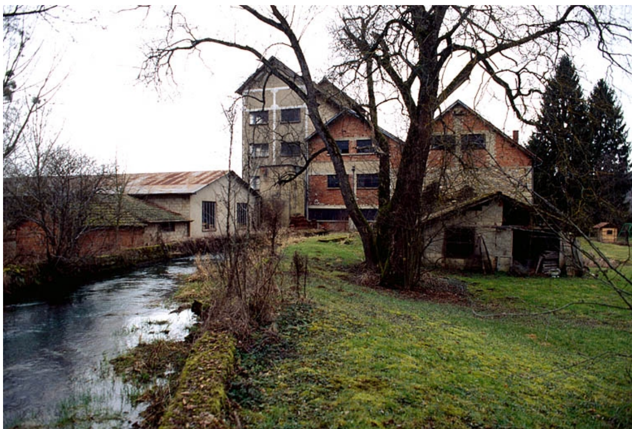
Façades postérieures depuis le canal d'amenée.
