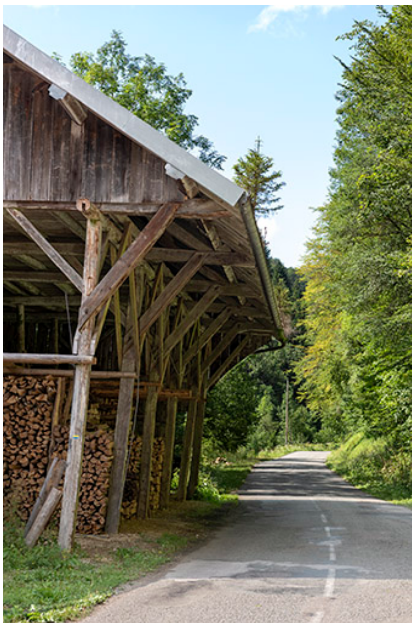
Hangar, depuis le sud.
