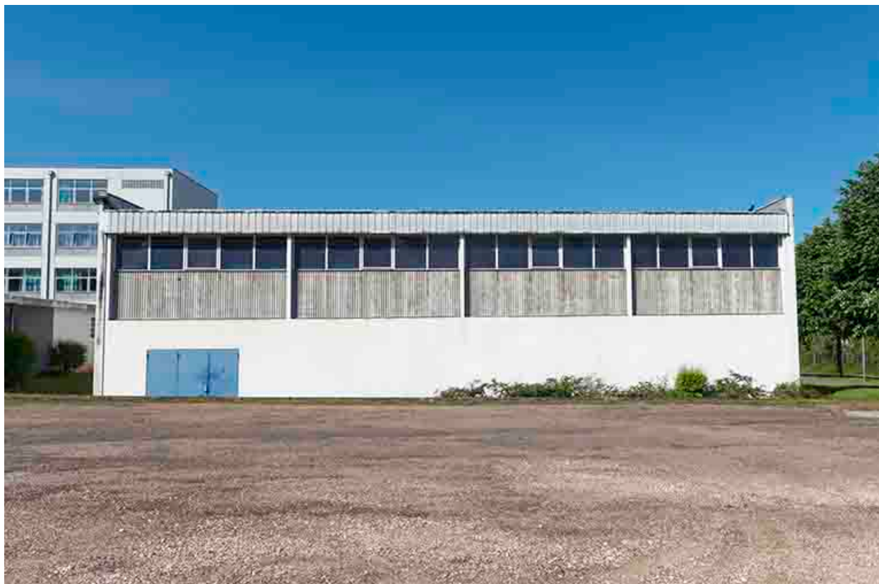
Façade nord-est du gymnase.
