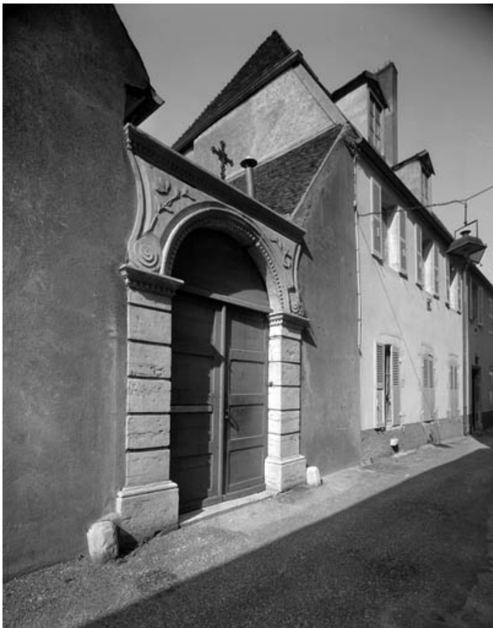
Le portail d'entrée de la cour.
