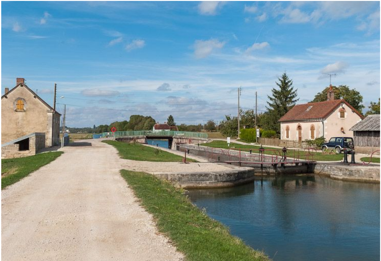
Vue d'ensemble du site d'écluse, avec de gauche à droite, la maison éclusière et la maison de garde.
