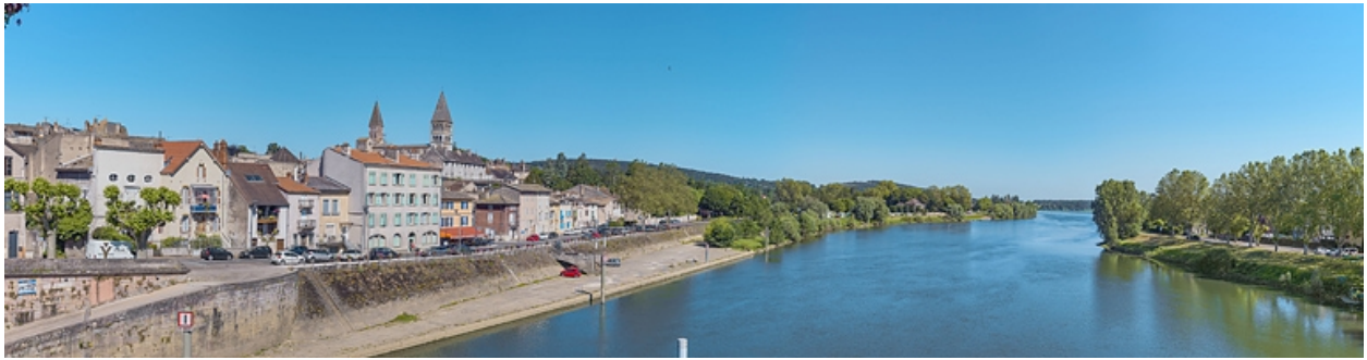
Vue d'ensemble du quai du Nord depuis le pont.
