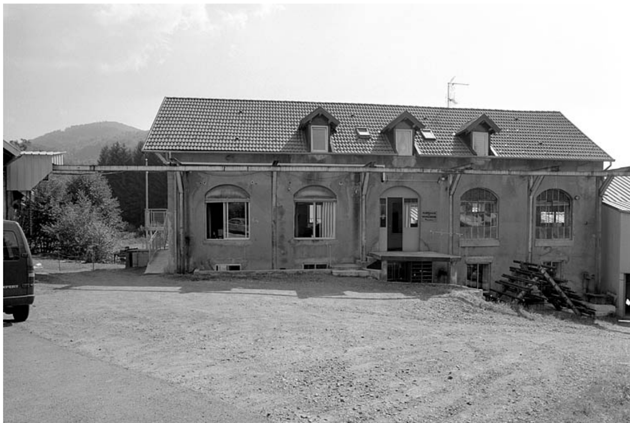
Façade ouest de l'atelier de fabrication primitif.
