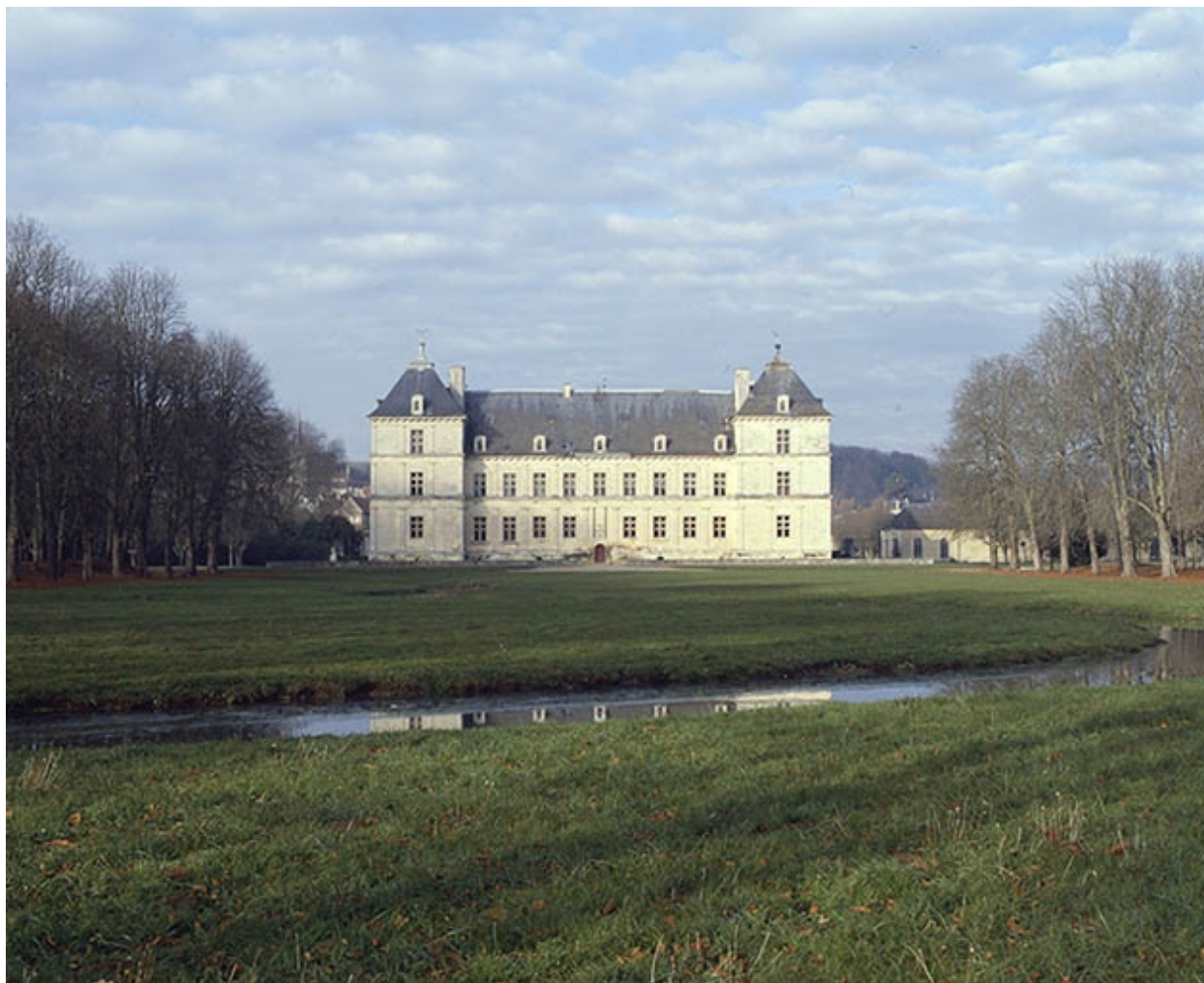
Vue d'ensemble de l'élévation sud.
