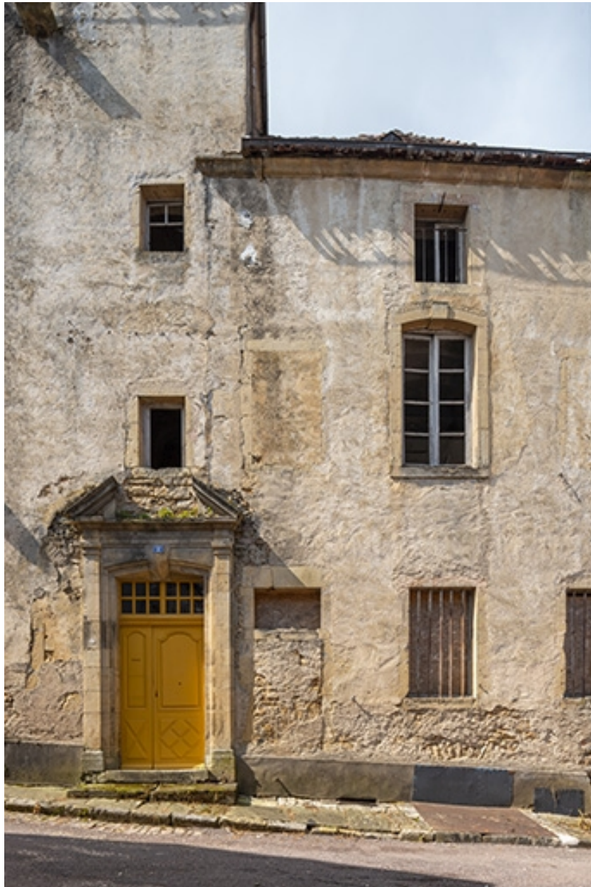
Détail de la façade orientale et de la porte située à la base de la tour.
