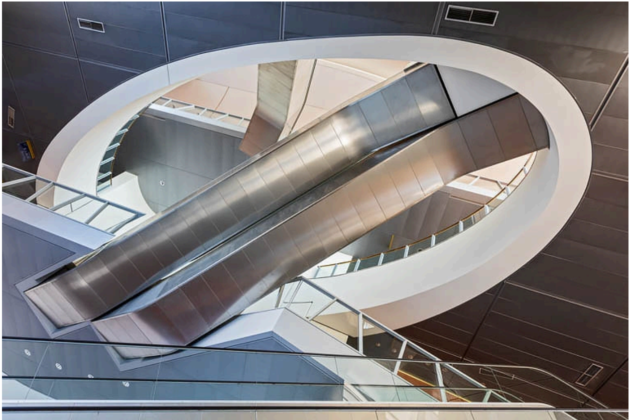
Foyer nord : escaliers mécaniques, vus en contre-plongée.
