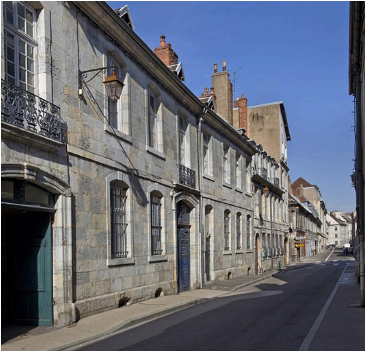
Vue d'ensemble depuis la rue, de trois quarts gauche.
