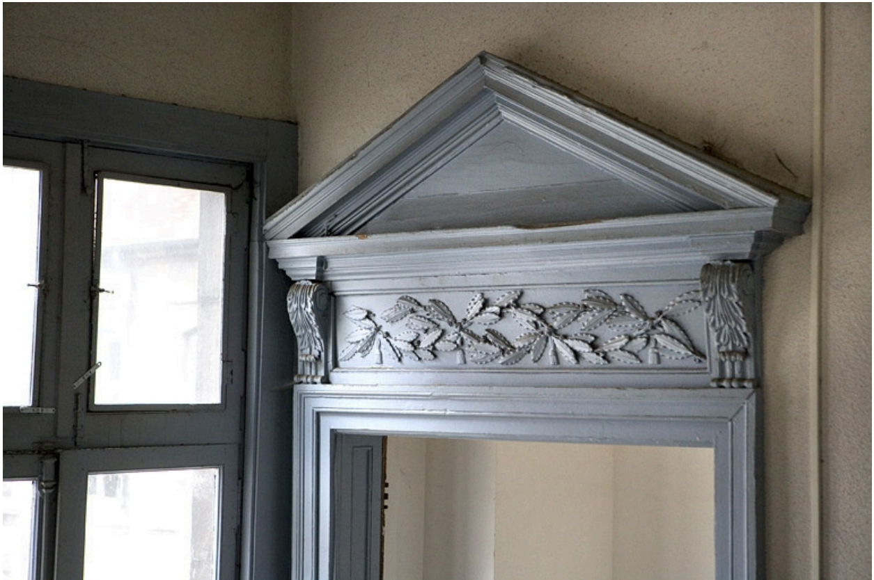
Détail d'un dessus de porte du premier étage.
