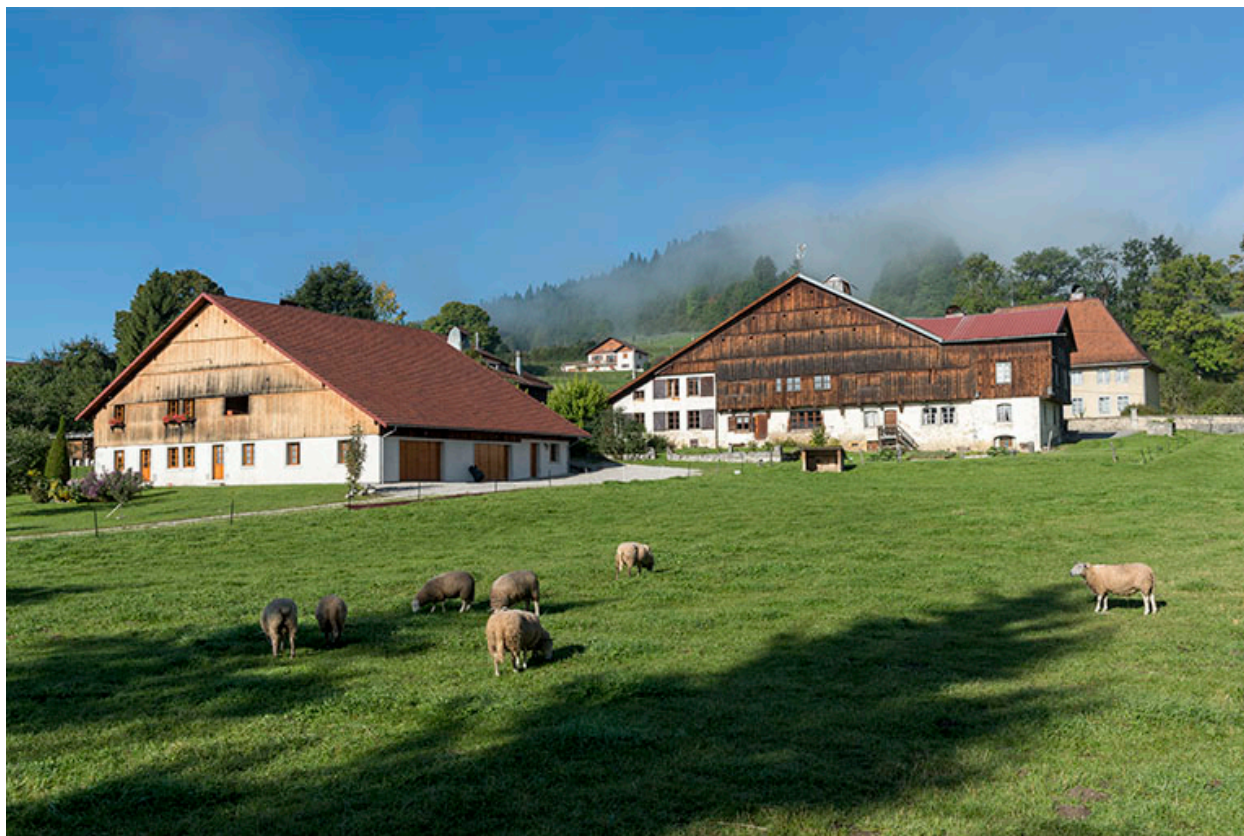
Vue d'ensemble éloignée, depuis l'est.
