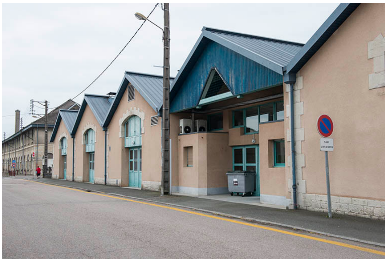
Façade nord de la cantine.
