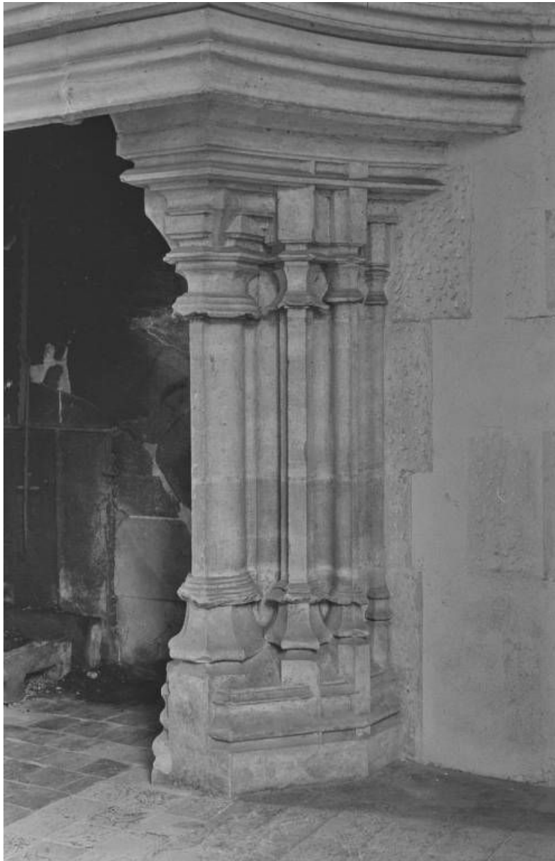
Cheminée (rez-de-chaussée) : détail du montant (photo prise en 1969).
