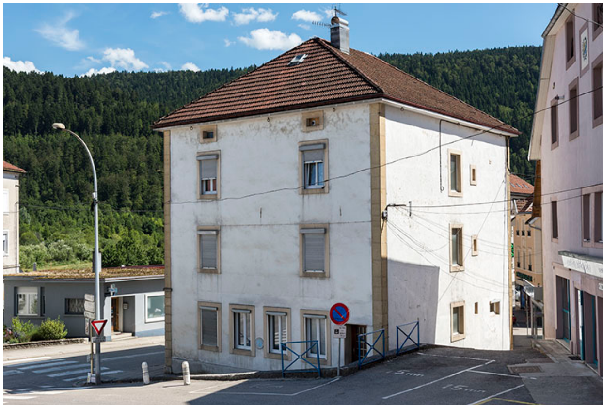
Façades postérieure et latérale droite.
