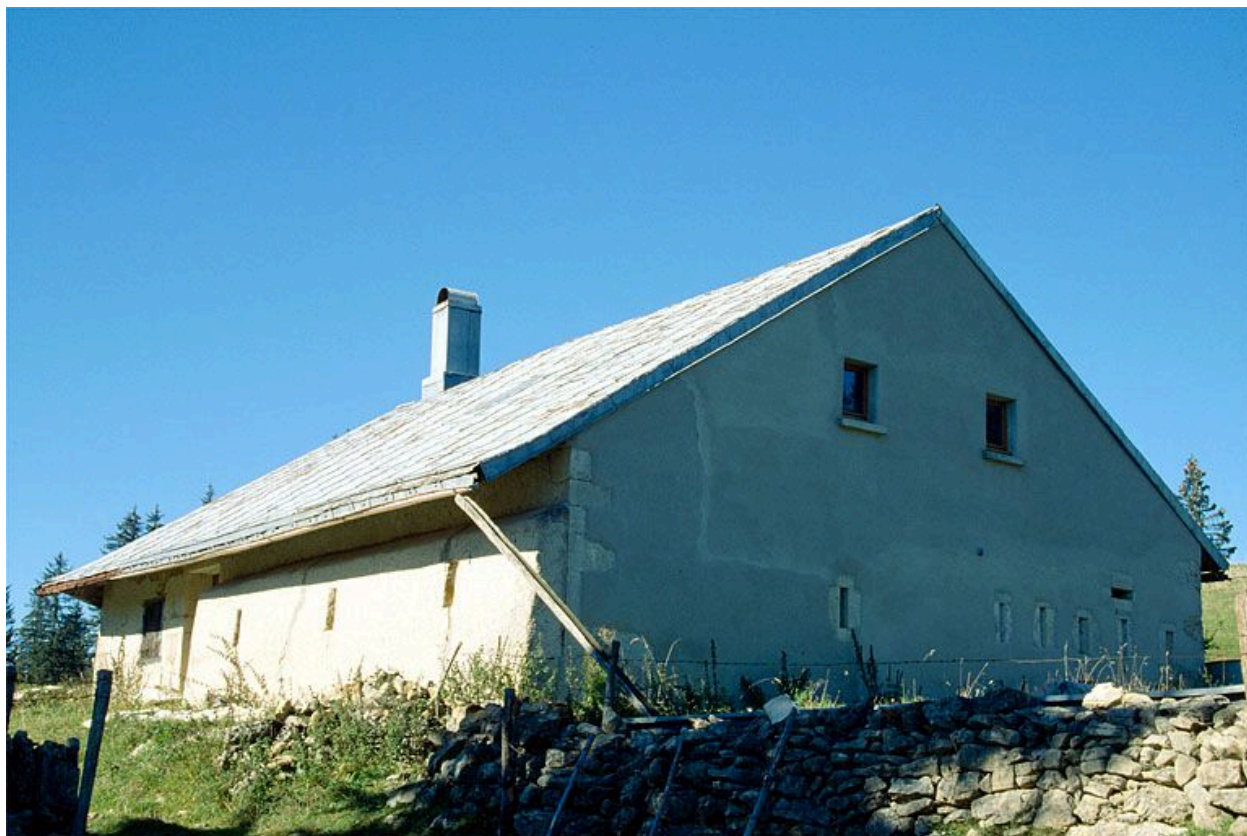
Façade antérieure et face droite.
