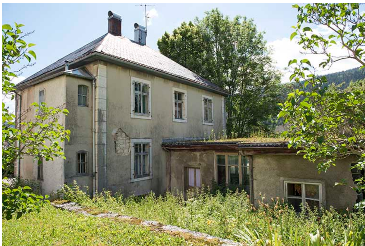
Façade postérieure et atelier de fabrication.
