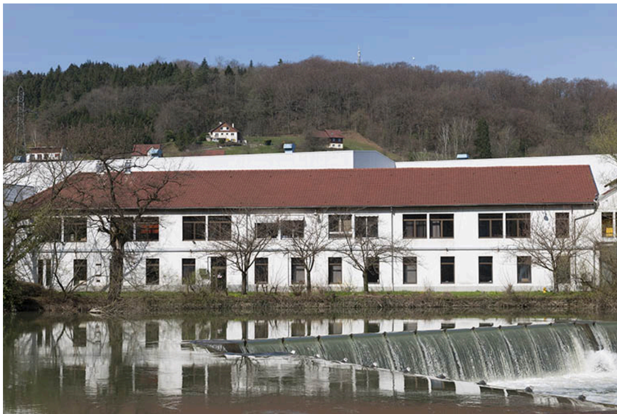
Bâtiment industriel de la rive gauche.
